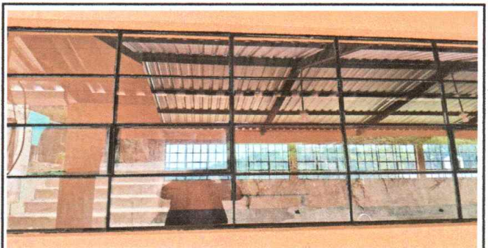
Foto 6: sustitución de vidrios de ventana
