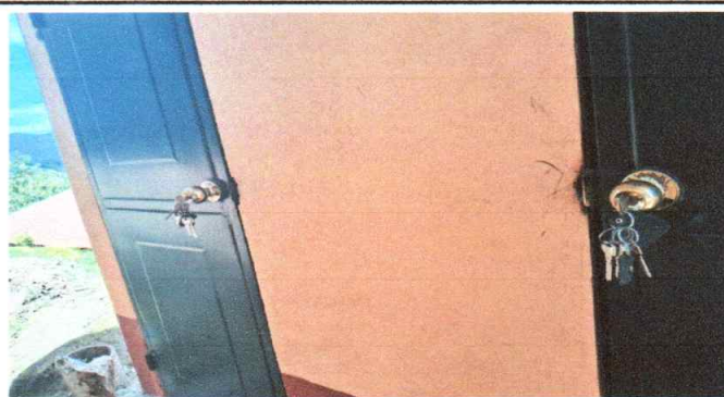
Foto 8: sustitución de puertas para servicio sanitario
