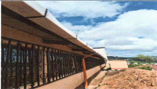
Foto 3: sustitución de canal metal
