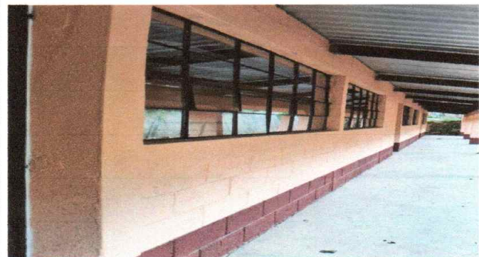
Foto 9: sustitución de vidrios de ventana
