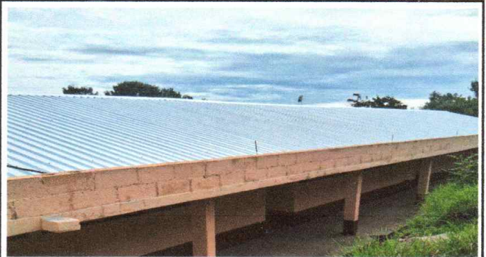
Foto 4: sustitución de lamina, por lámina troquelado aluzinc calibre 26
