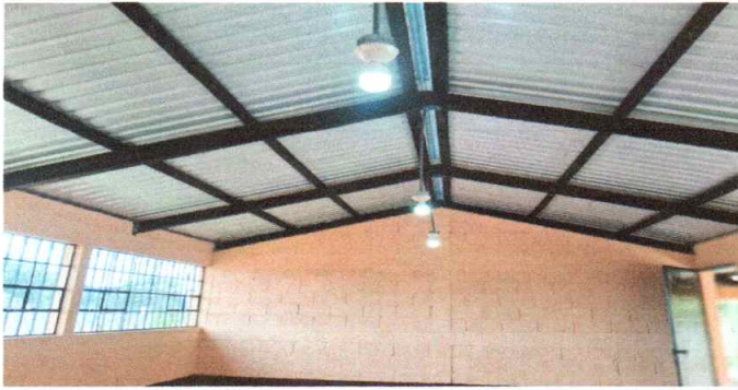
Foto1: reparación de sistema electrico
