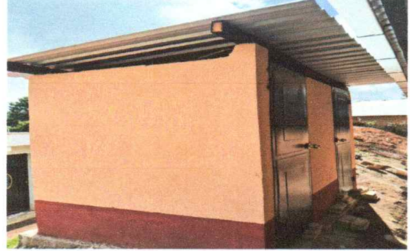
Foto 2: sustitución de pared de madera por block para servicio sanitario
